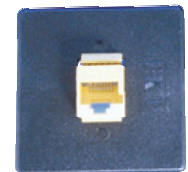
Data socket (RJ-45) 4C 12-D Data soketi
